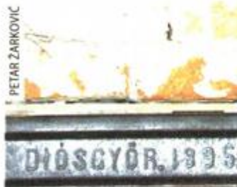
Dio željezničke šine
